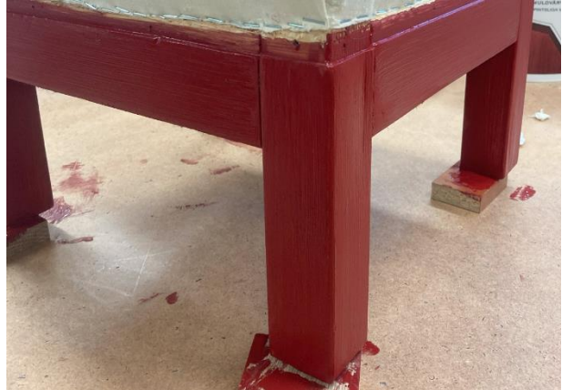
Foto 120. Rootsi muldvärviga värvitud raam.
