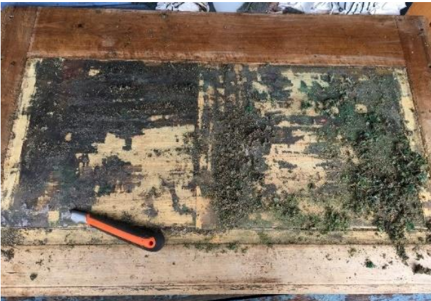
Pilt 49 – vana kalevi eemaldamine
