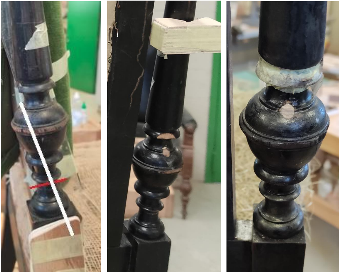
Katkise samba parandamise tööjärgud
