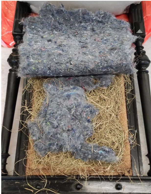
Seljatoe polstri tegemise etapp ja polstriraami tagaküljele klammerdatud papp
