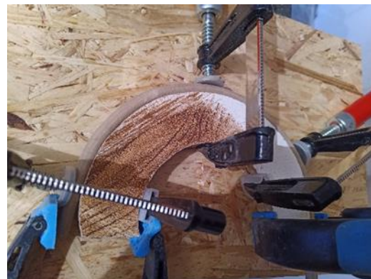
Vankri ratta detail on aurutatud ning paigaldatud rakisele kuivama.
