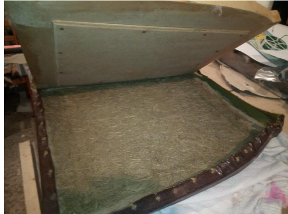
Pealiskate on lahti võetud ning näha on, et puidu peale on lahtiselt paigaldatud merihein. Meriheina ja kunstnaha vahel on tasandav kiht vatti.
