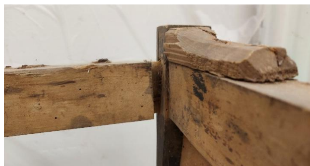
Joonis 18-20 Tugevdusklotsid, avatud tapid ja murdumisesl eemaldunud osa puudumine
